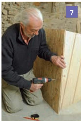
**7** De chaque côté, solidarisez le toit avec le montant du côté par une vis de 55 mm.
