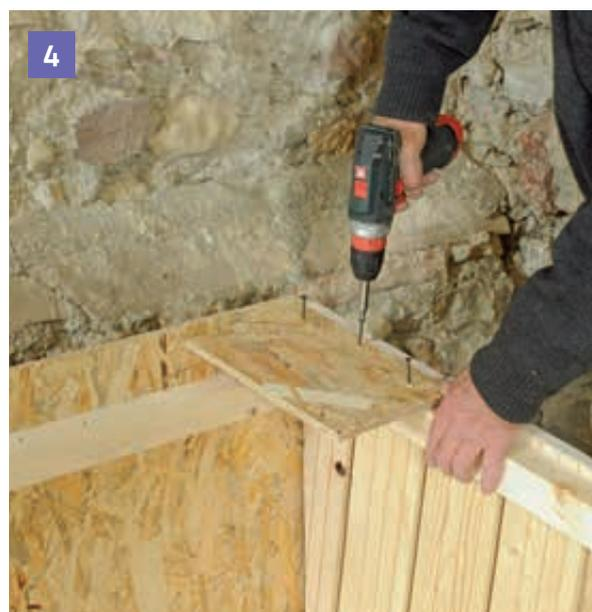
**3** Assemblez le côté avec le toit avec une vis de 70 mm.
