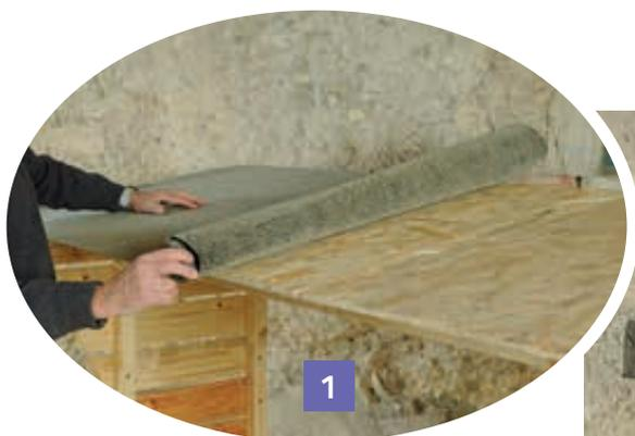
**1** Déroulez la toile bitumée sur le toit de l'abri en la faisant dépasser de 5 cm à l'avant et 15 cm à l'arrière.
