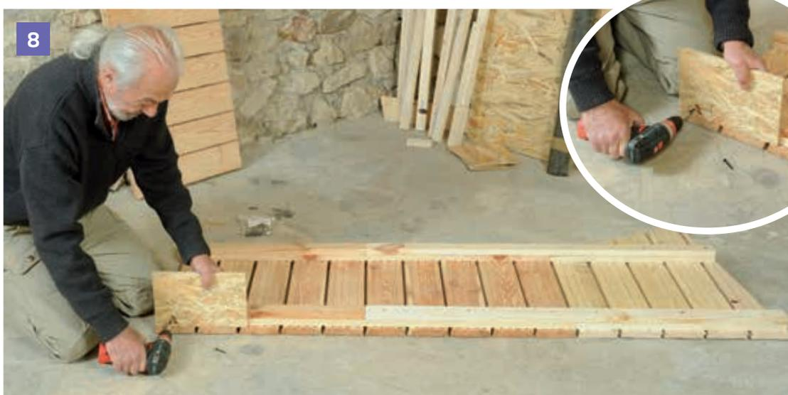
**9** Assemblez les deux panneaux de couverture avec les tasseaux de 1200 mm.
